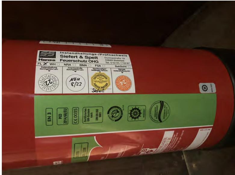
Abbildung 8: Neuer Schaumlöcher im Logis-Bereich - Wheelmark
