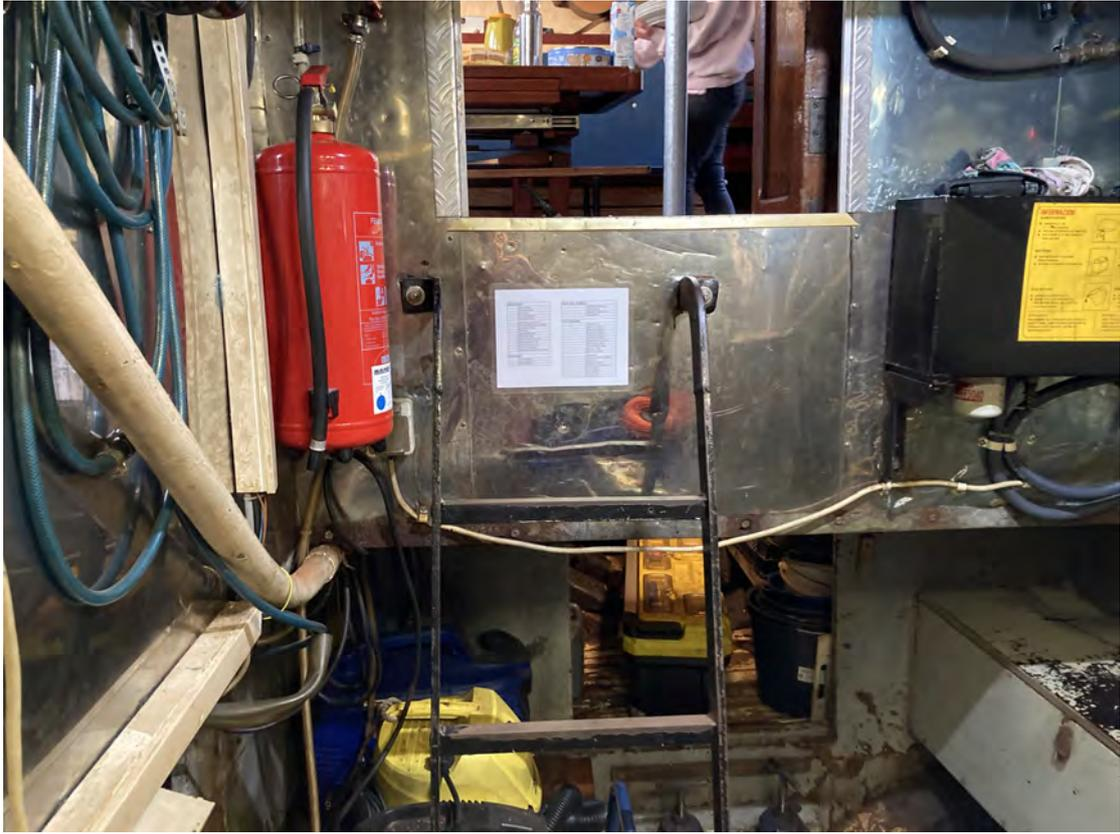
Abbildung 3: Neu aufgestellter ABC-Pulverlöscher im MR
