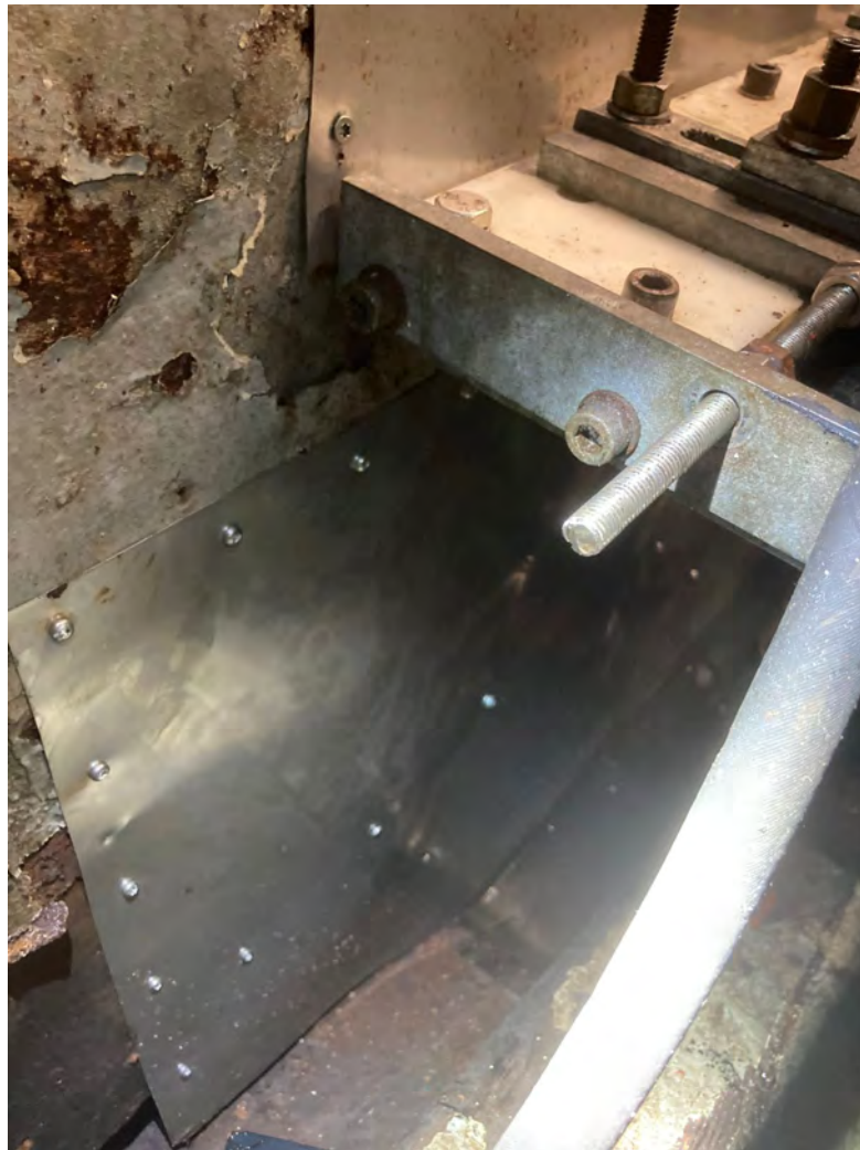
(c) Blechplatte, Blick von Bb
