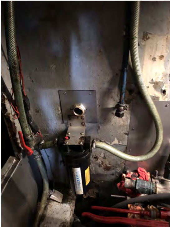
(a) Ausführung der Schottdurchführung Bb Seite
