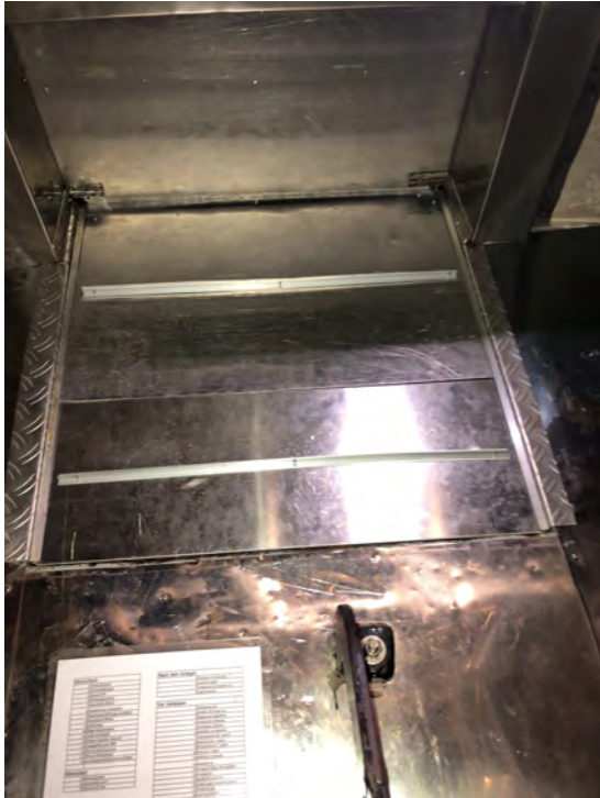
(c) Neue, versteifte Steckbleche
