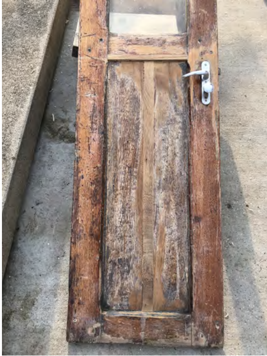
(a) Salontür, ausgebaut, mittig neu verbautes Holz
