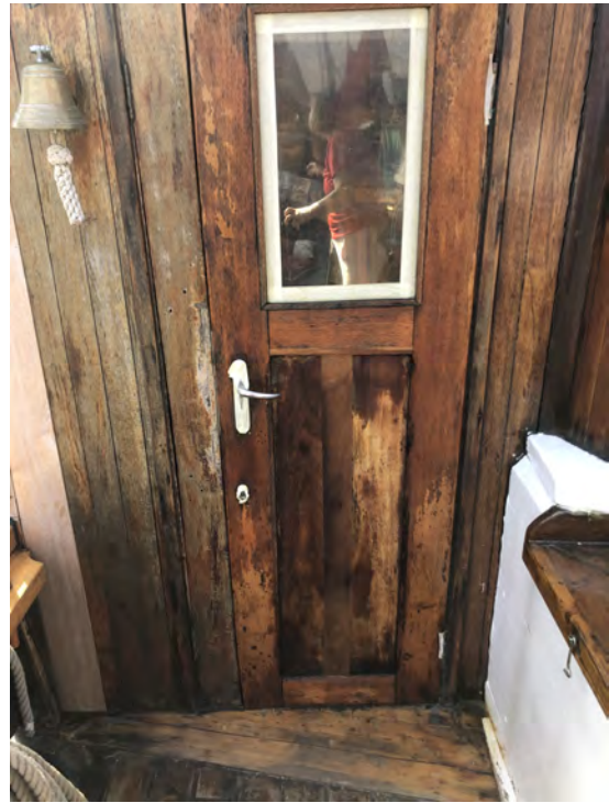
(b) Salontür wieder eingebaut von außen
