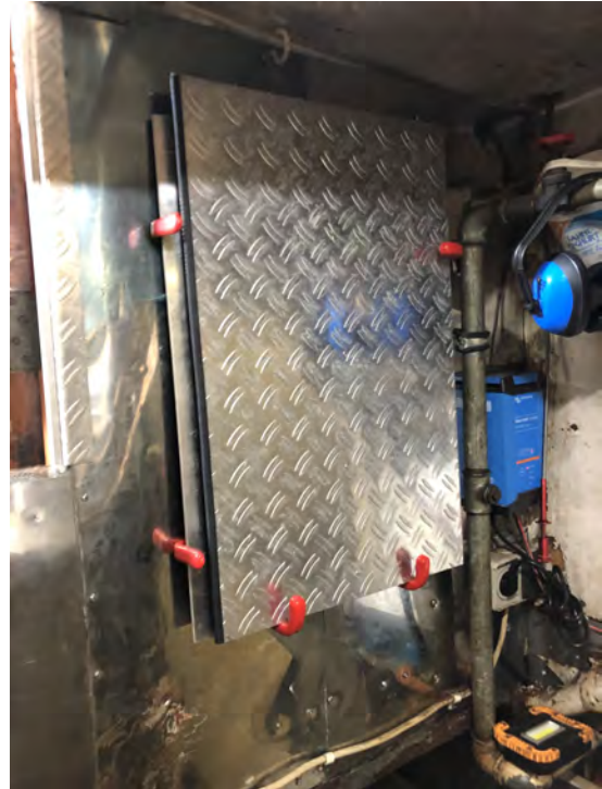
(d) Blechlagerorte direkt neben der MR-Tür
