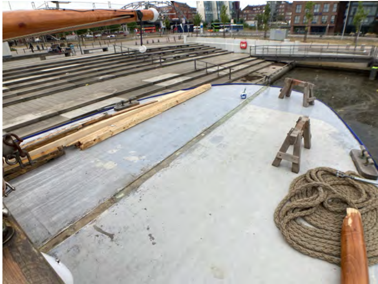
(a) Kompletter entfernter Tragbalken auf dem Achterdeck. Das GFK ist über die komplette Länge des Tragbalkens ergänzt worden.
